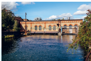
Kraftwerk am Stadtbach 12
