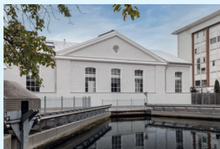
Kraftwerk am Senkelbach 17
