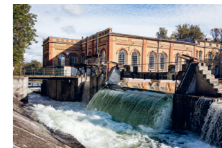
Kraftwerk an der Wolfzahnau 15
