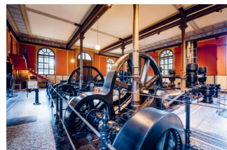
Wasserwerk am Hochablass 11
